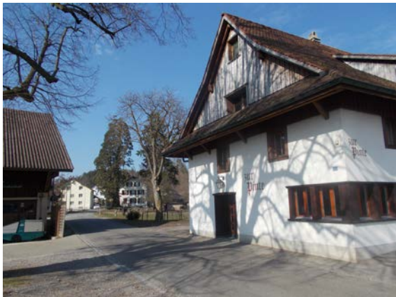
a.) Ansicht Südfassade Rest. Pinte mit Zugang von der Dorfstrasse
