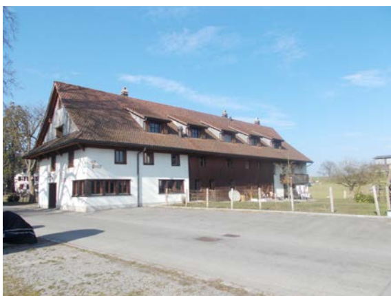
c.) Ansicht der Südostfassade Rest. Pinte
