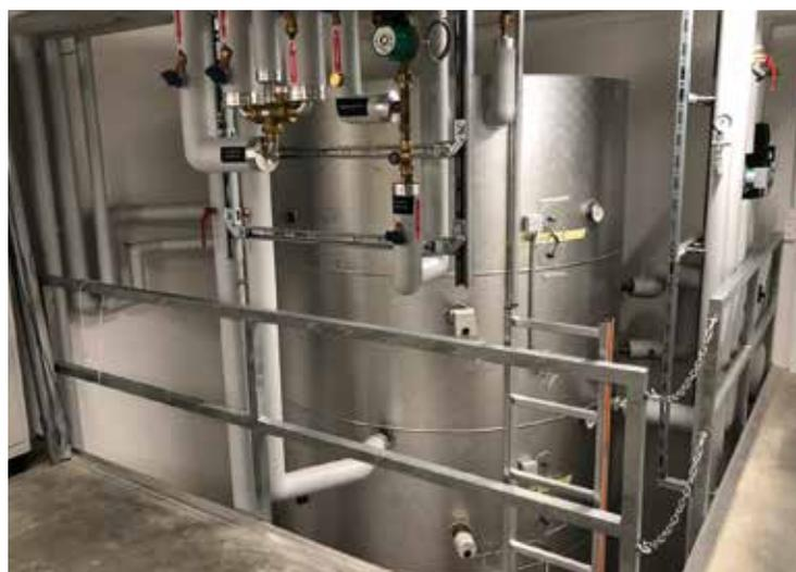
Der 12'600 Liter fassende Kombispeicher für Heizung und Warmwasser.
